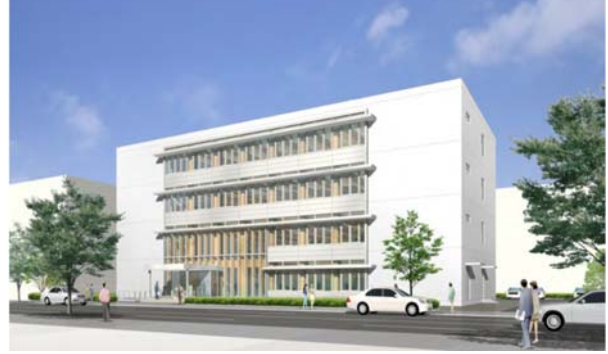
ケースB: 平面混構造4階(RC造+木造) 燃え止り型
