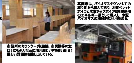
真庭市は、バイオマスタウンとしての取り組みも進んでおり、木質ペレットボイラと木質チップボイラを冷暖房用のエネルギー源として導入し、木質バイオマスの積極的な利用を図る。
