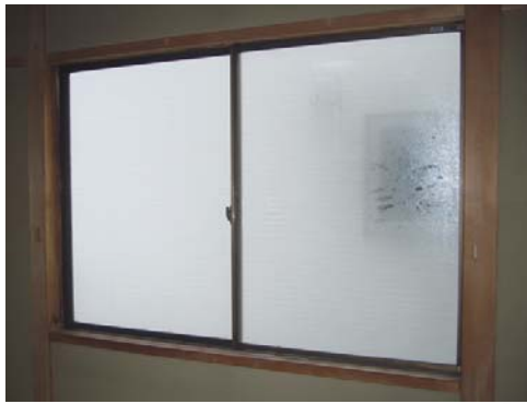
結露だらけのアルミサッシ
