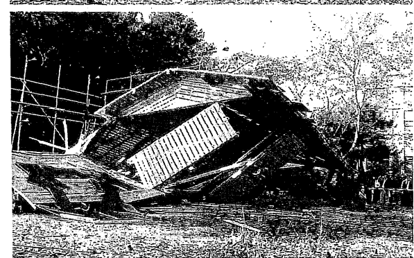
木造家屋が倒れる瞬間。1階部分がまっすつぶれ、地面に投げ出された2階部分が崩壊した(宇治市で)
