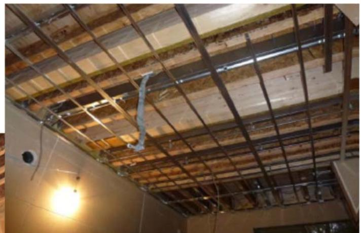
Iジョイスト耐火床の軽天構造（施工例）
