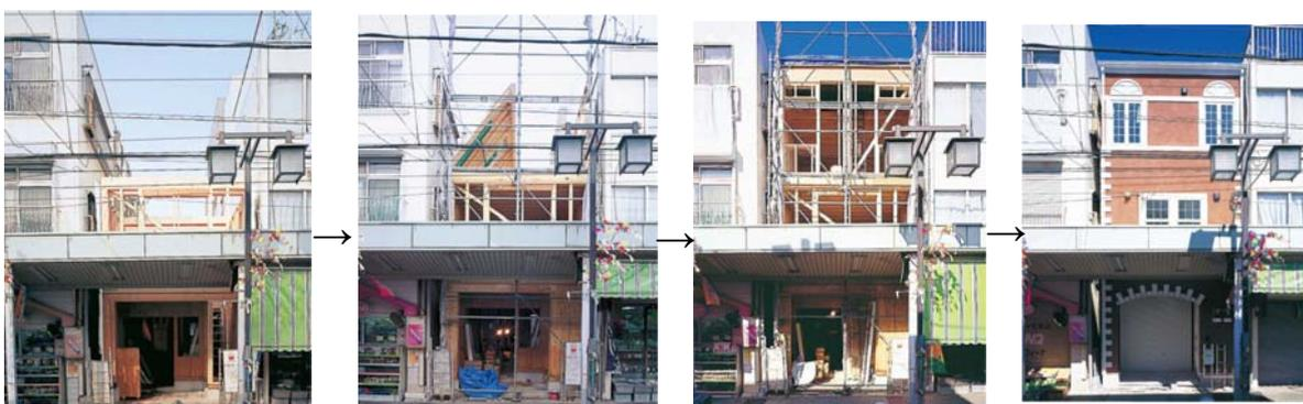
建て起こし装置による耐火建て起し工法の施工例
