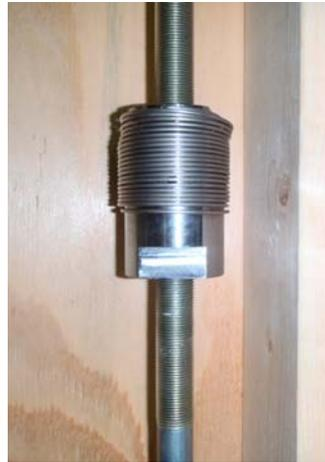
中層建築の沈みこみに対応したオリジナルスプリングカプラー（高強度鋼）
