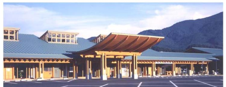
集成材フレーム+米松LVL折板トラス構造/Glulam Frame, LVL\* Truss Structure
