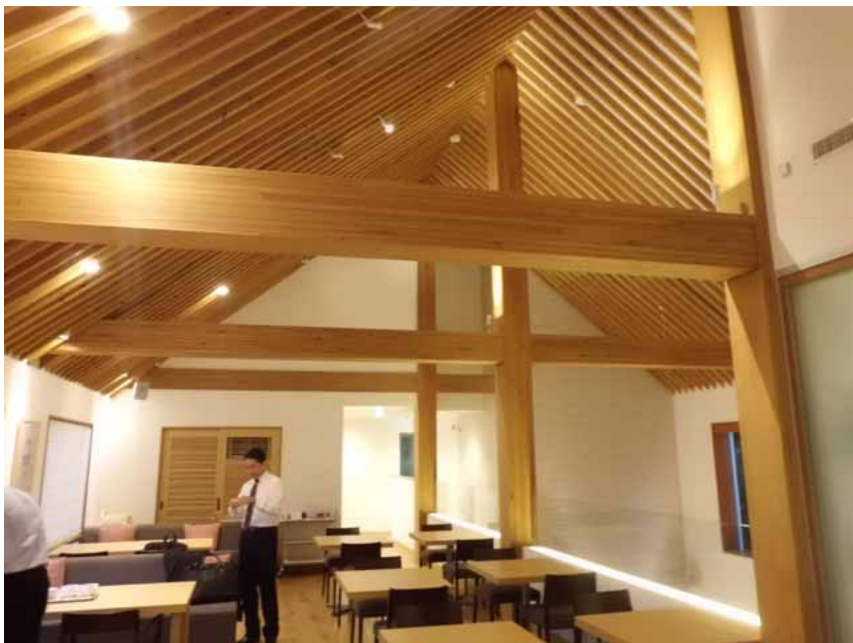
耐火集成材「FRウッド」を使った店舗の内部
