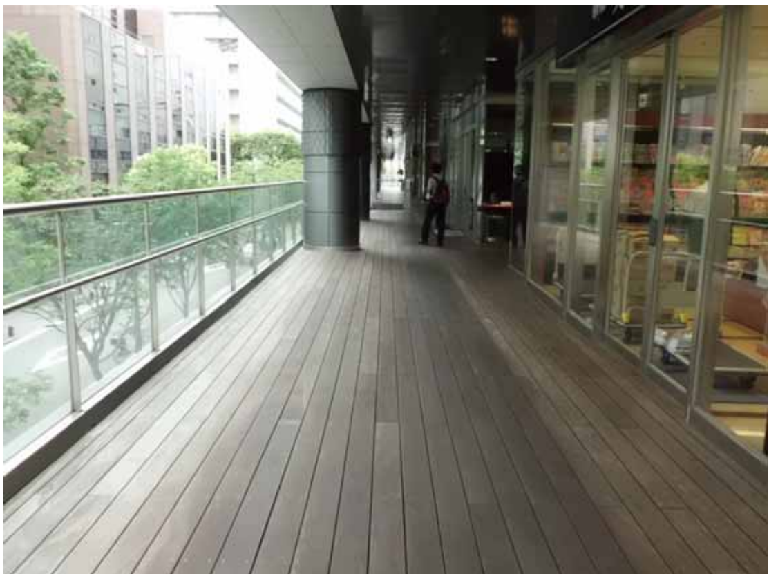
2階外周部に設置されたデッキ(デッキから直接各店舗に入店可能)
