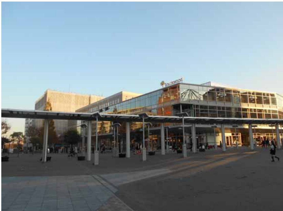
竹中工務店「燃エンウッド」で作られた大型建築(2～4階に使用)
