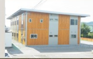
W.A.L.Cを用いた事務所棟 一階が研修室のため長期計画が可能
