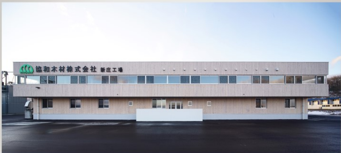
協和木材株式会社山形新庄工場 構造：鉄骨造+W.ALC 延床面積：607.90㎡ W.ALC使用量：44.90㎡
