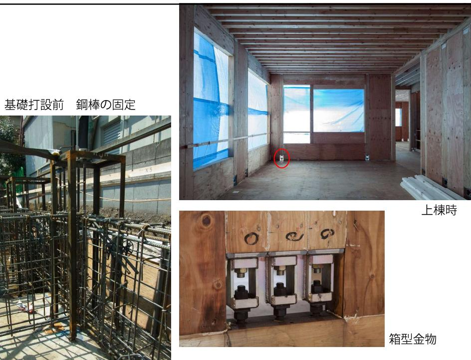
基礎打設前 鋼棒の固定
