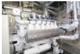
ガスエンジン
