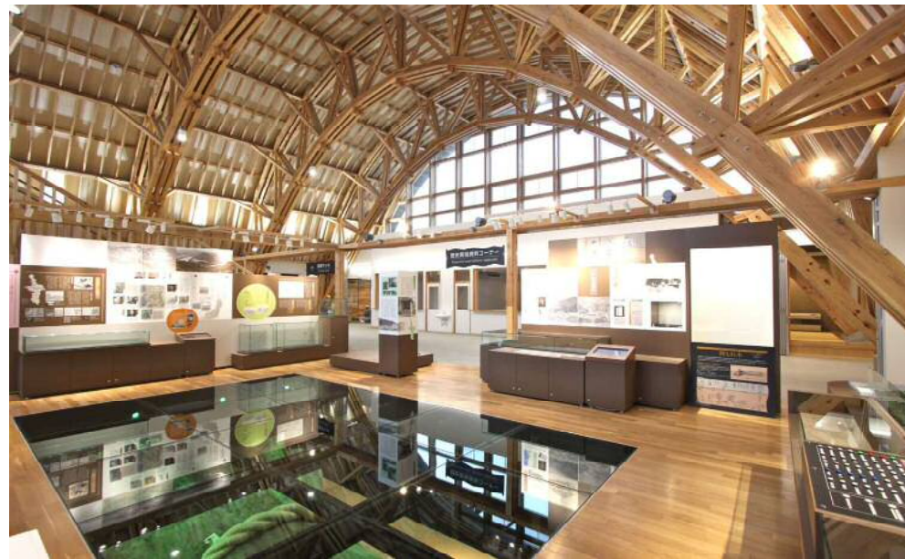
4寸×8寸×長3mスギ製材で構成したアーチトラス
