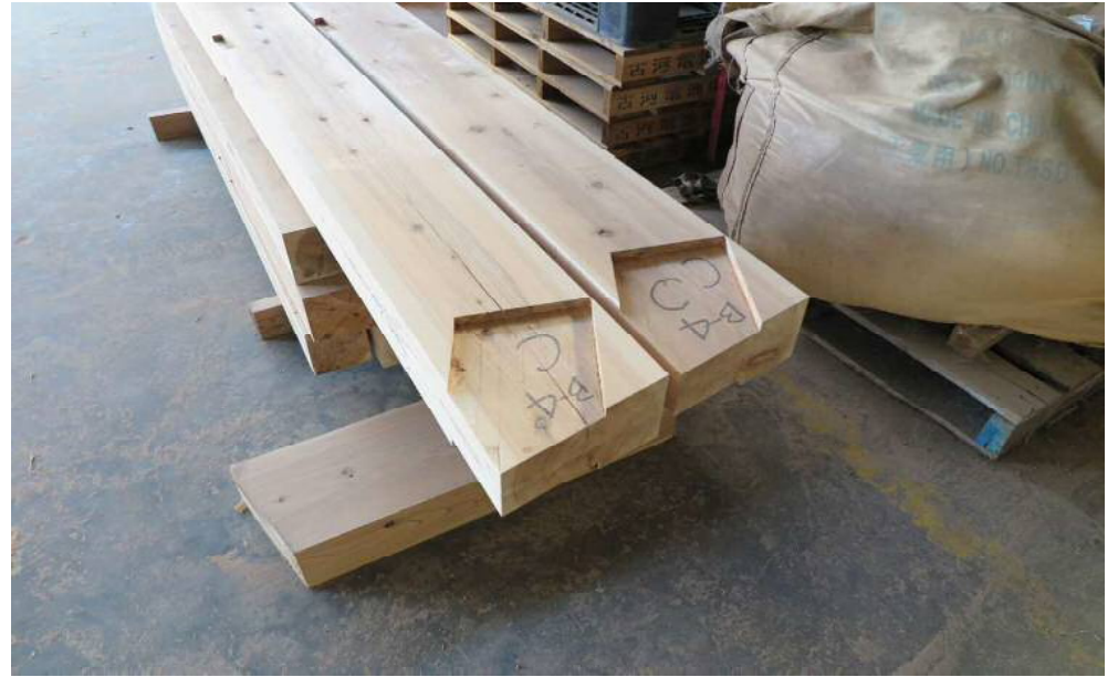
舟底型の張弦トラス 嵌合部の加工
