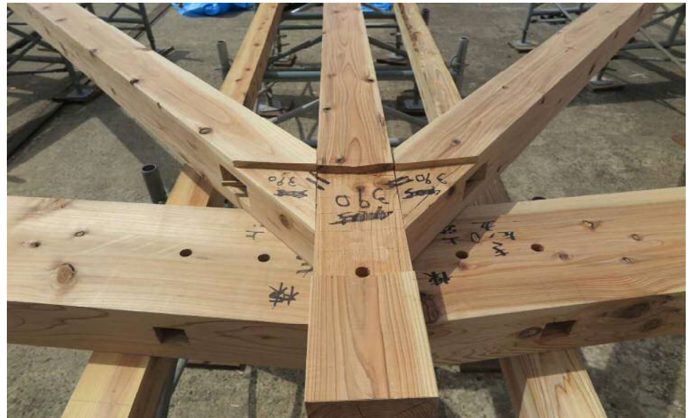
アーチトラス仮組み
