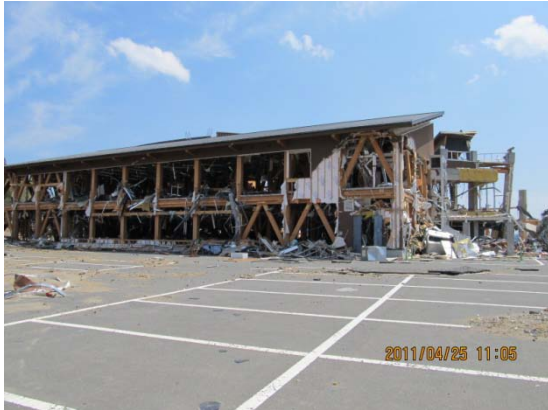
写真1 北上総合支所大断面木造ラーメン
