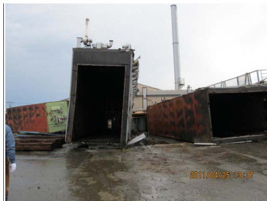
写真 6 転倒した乾燥炉
