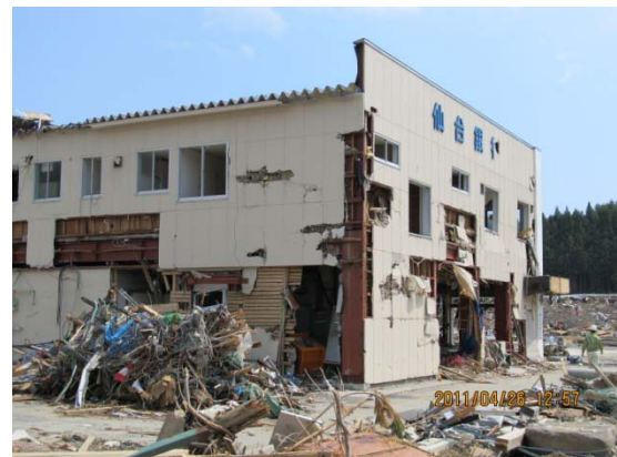
写真 24 低層 S 造建築物
