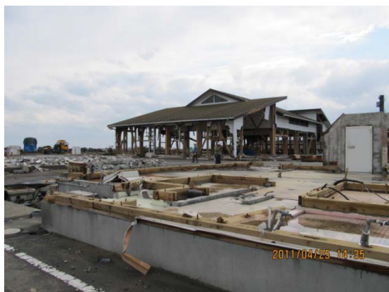
写真 11 柱を残して建っている木造
