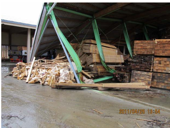
写真 7 S造製品倉庫
