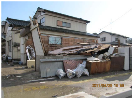
写真 13 津波被害の隣接地域の住宅
