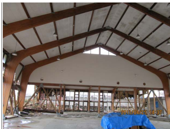
写真 12 その木造の内部
