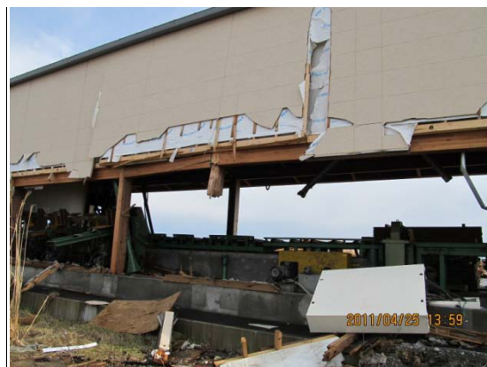
写真 8 木造ラーメン製品倉庫
