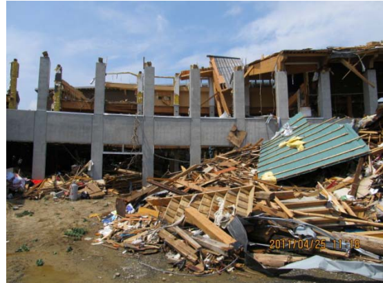
写真2 北上総合支所の海側はRC造柱
