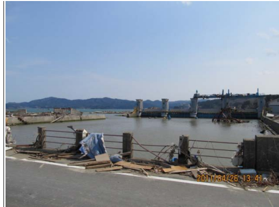
写真 26 残骸を留める鉄道の橋脚
