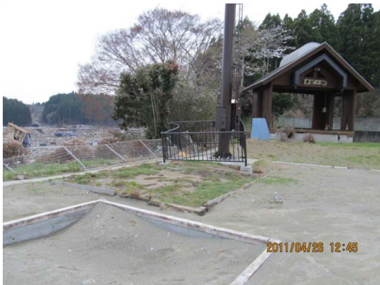
写真 21 高台のフェンス、照明ガードフェンス
