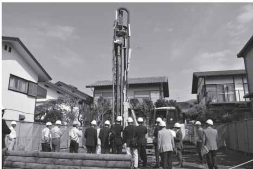
環境パイル工法施工現場視察の様子
