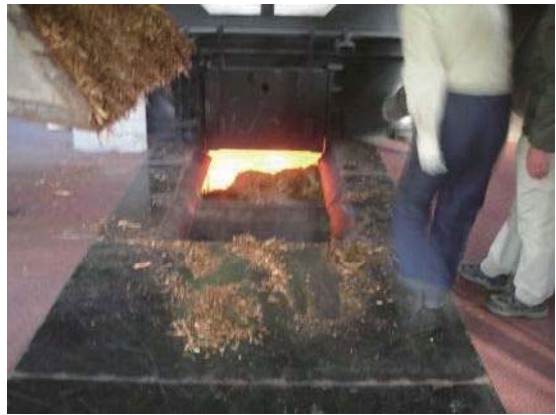
写真 2.12.28 ボイラによる燃焼
