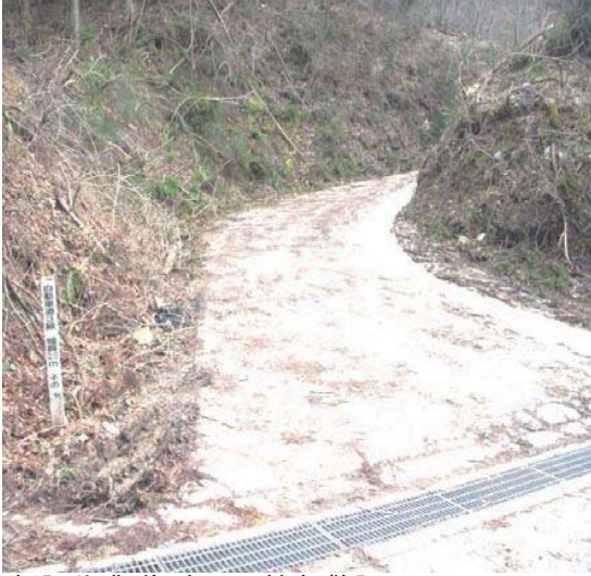
新設作業道(路面に枝条敷設)
