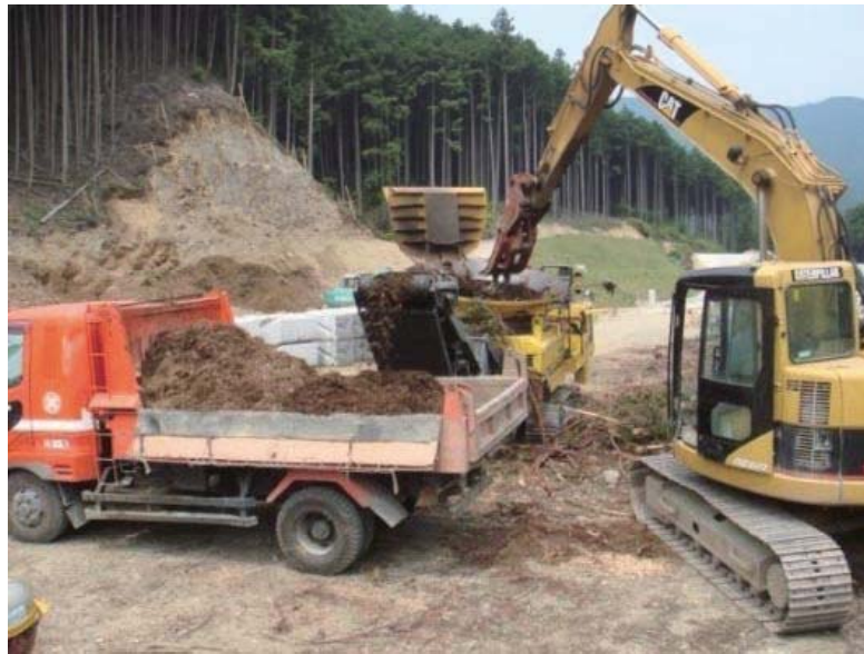
写真 2.9.7 ダンプトラックへの積み込み
