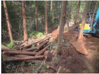
写真 2.12.1 自力間伐状況
