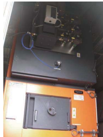
写真 2.12.22 チップボイラー (SCHMID 社)
