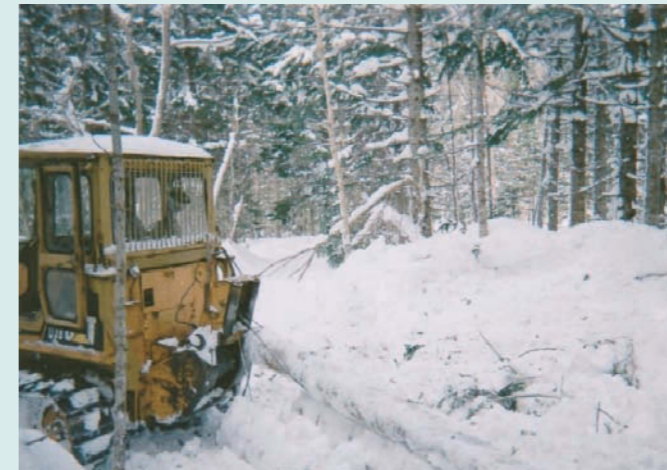
ブルドーザ木寄・集材作業
