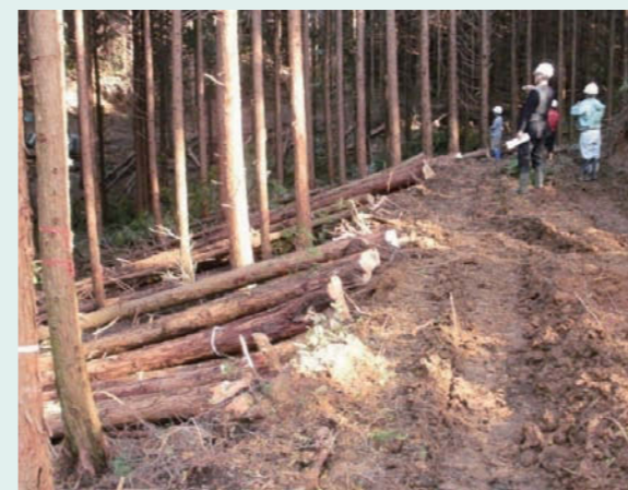
作業路と路側の木寄状況
