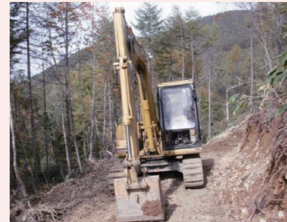
バックフォー作業路作設作業
