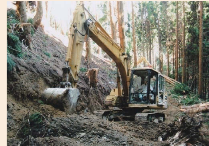
バックフォア作業路作設作業
