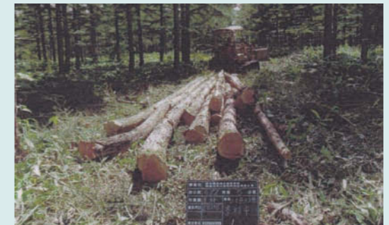
ブルドーザ集材作業
