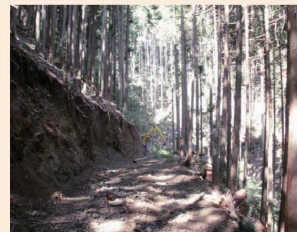
バックフォー作業路作設作業
