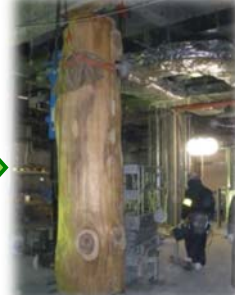
出発ロビー設置中
