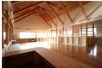
図書室 (小屋組みを現しつつ開放感を確保)
