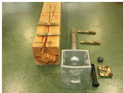
写真 3.5.4-28 20RDSP-3 木材の割れ
