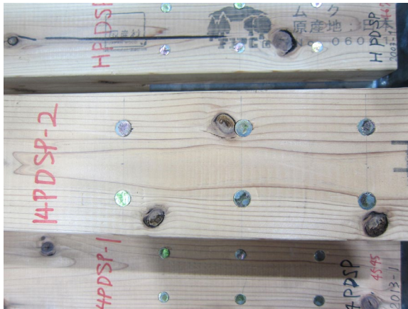
写真 3.6.4-3 KDG14 試験体の調湿後の様子
