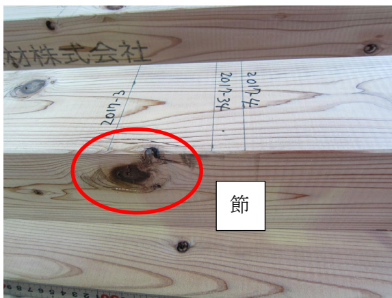
写真 3.4.3-3 節がある部分を避けて材料取り
