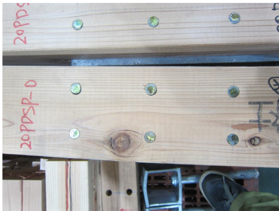
写真 3.6.4-5 KDG20 試験体の調湿後の様子
