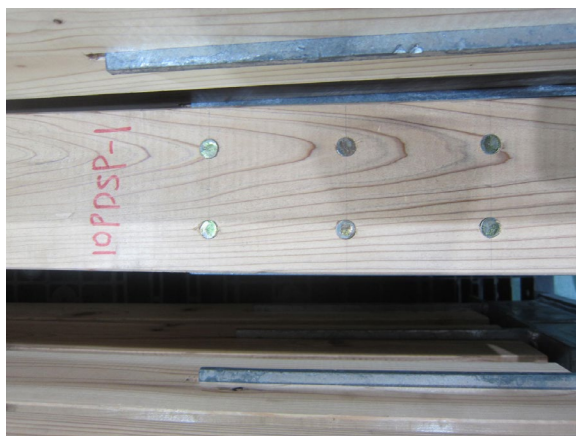
写真 3.6.4-1 KDG10 試験体の調湿後の様子
