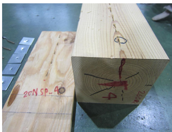
写真 3.5.1-21 20NSP-4 くぎ列に沿った割れ、木口割れ
