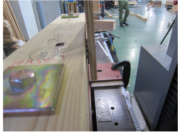
写真 3.5.2-3 10NSO-5 合板の浮き
