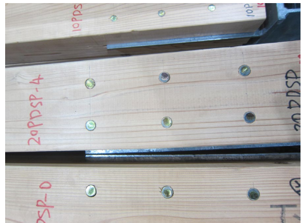
写真 3.6.4-6 KDG20 試験体の調湿後の様子
