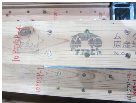
写真 3.6.4-2 KDG10 試験体の調湿後の様子
