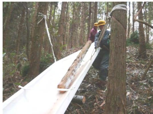
写真 2.2.24 SWC への間伐材の投入
