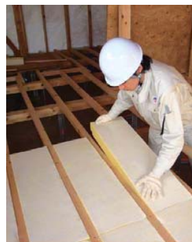
床の断熱工事
