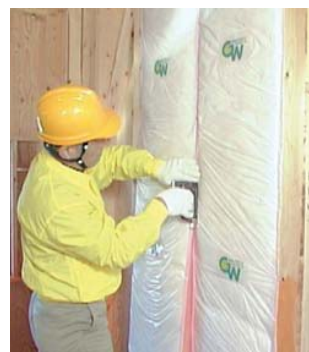
壁の断熱工事
