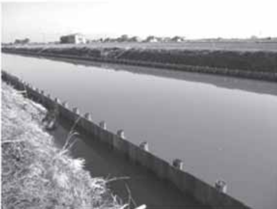
写真-8 蓮池土留板柵工
