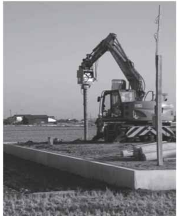
写真-9 住宅基礎杭
