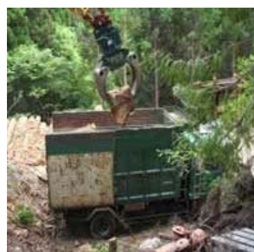
写真 1. 11. 2 小型ダンプ車（6～8t）への端材、短尺材の積載
