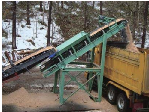
写真 2.2.27 破碎・積込作業
