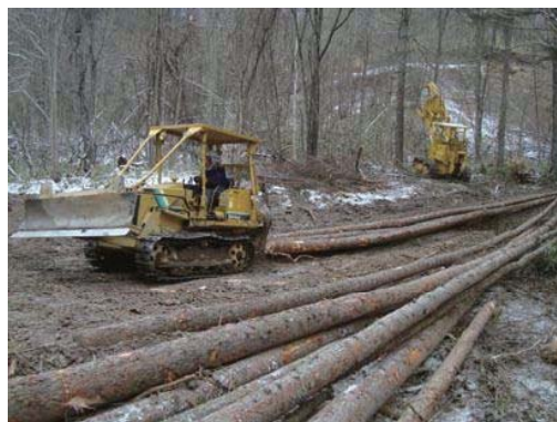
写真 2.2.16 ブルドーザー集材
