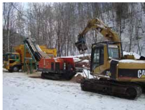
写真 1.2.4 現地における破碎・積込作業
