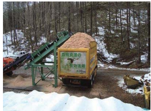
写真 2.2.28 破碎・積込作業
