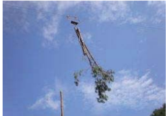
写真 2.5.27 木寄・集材（架線・全木）
