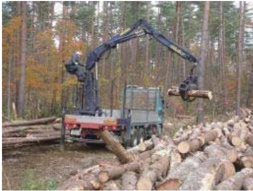
写真 2.5.16 積込・輸送（グラップル付 10 t トラック）
