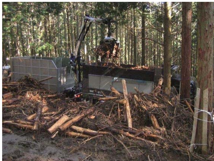
写真 2.6.19 ツカミ付きのトラックと深底ダンプを併走させて、現場での作業日数を低減させた。
