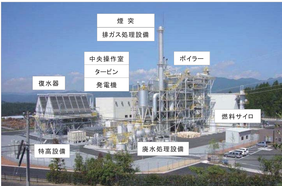
図2.7.9 バイオマス発電所の外観 (日田発電所)
