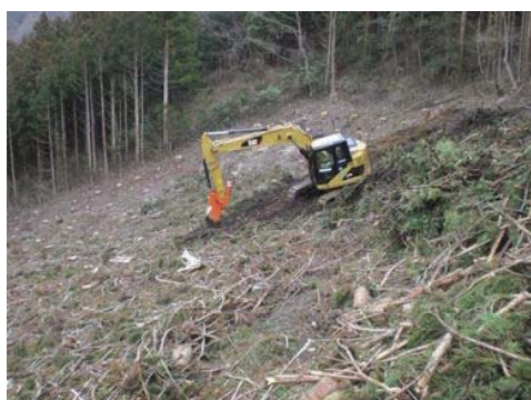
写真 2.6.14 作業道開設
