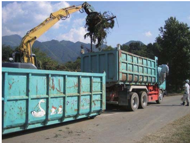
写真 2.6.6 アームロール車やダンプを次々と投入し、積込作業者の手待ち時間を少なくした。
