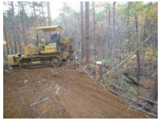
写真2.5.13 木寄・集材（ブルドーザ）
