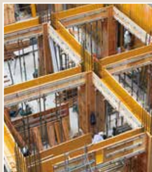
■鉄筋コンクリート造
