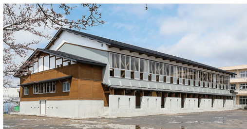
南東側外観全景。
