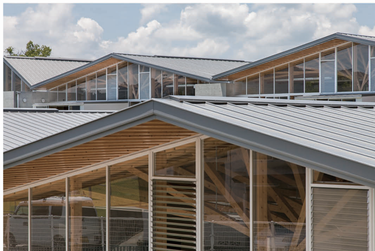
南より妻側が開放された普通教室の屋根架構を見る。手前に平屋の低学年教室、奥に2階の高学年教室。*
