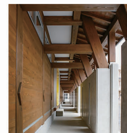
東側外部通路。RC造の腰壁が基礎となる。冬期間の通路を確保。
