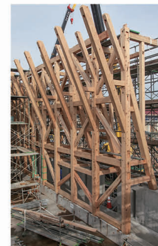
柱と控え柱を地組みして建て込む。
