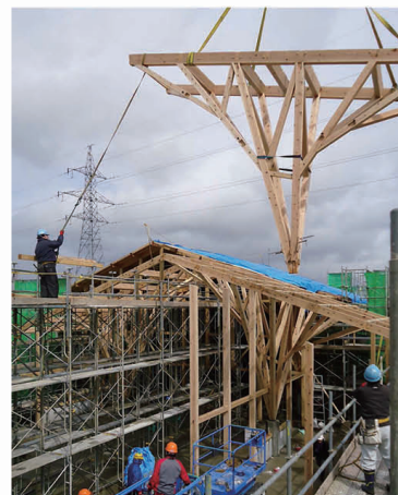
クレーンによる建て方。
