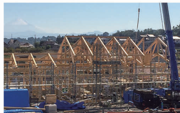
3歳未満児保育室部分の建て方風景。
