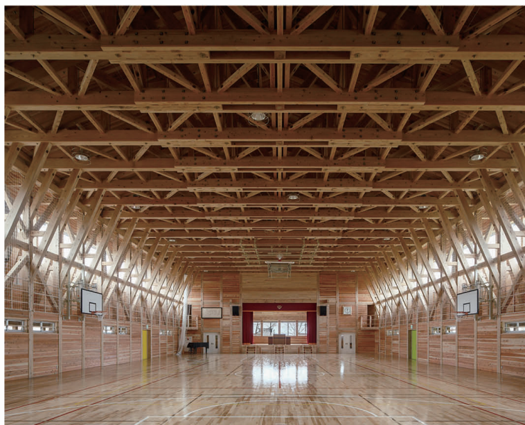
アリーナ ステージ方向を見る。アリーナは18m×36m。18mスパンを1.8mピッチのトラスで飛ばしている。
