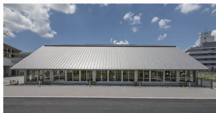
大屋根が葺き下ろされている図書室の平側（東側）外観。*
