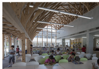
図書室内部。RC造と木造の組み合わせにより、平側にも開放的な空間をつくり出している。*
