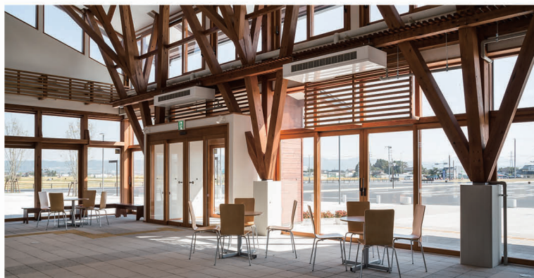
地域振興施設の中心「人のひろば」は、13.5mスパンを樹状トラスで飛ばし、アイレベルを開放している。*
