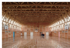
事例3：喜多方市立熊倉小学校体育館
