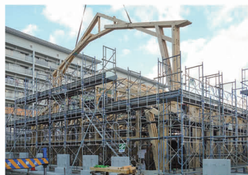
遊戯室部分の建て方風景。
