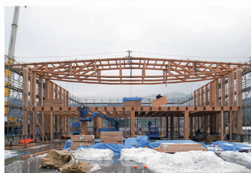
トラス建て方。工場で半分ずつ組み立て、現場で一体に組み立てた。1,820mmピッチで49ユニット。
