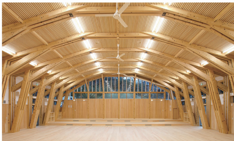
遊戯室。120mm角のヒノキ材の接着重ね梁・柱による架構。@1.82m。スパン14.56m。
