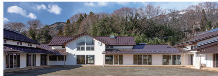
園庭より西方向を見る。
