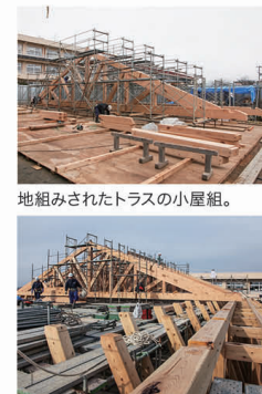
トラスの建て込み。
